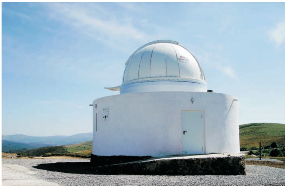
Observatorio astronómico de Forcarei, en construcción, con la cúpula colocada. Tiene ocho metros de diámetro de planta y cinco metros de diámetro de cúpula. Foto: Del autor
