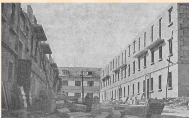
Bloques de "56 viviendas para clase media", en construcción
