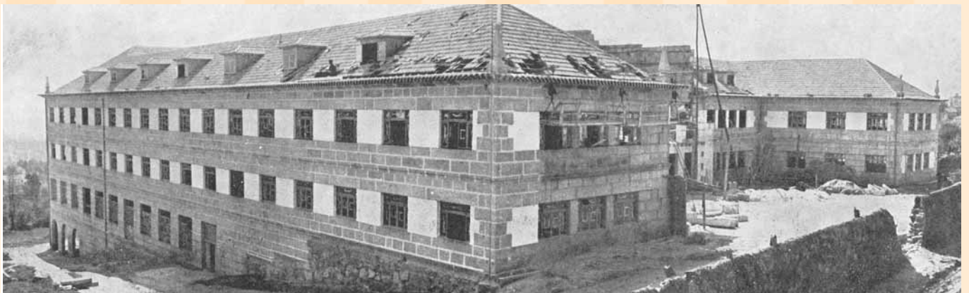
Fachada principal y lateral del Colegio Hogar en construcción
